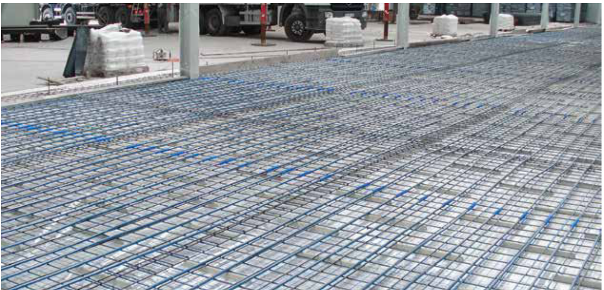
Slika 4. Instalacija podnog grijanja u industrijskom objektu, korištenjem bluePERT cijevi i KAN-therm NET sustava.
