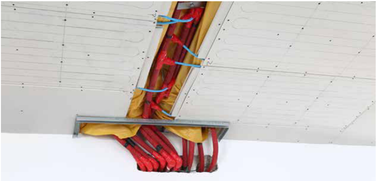
Slika 6. Instalacija stropnog hlađenja pomoću ploča za grijanje i hlađenje KAN-therm Wall sustava.
