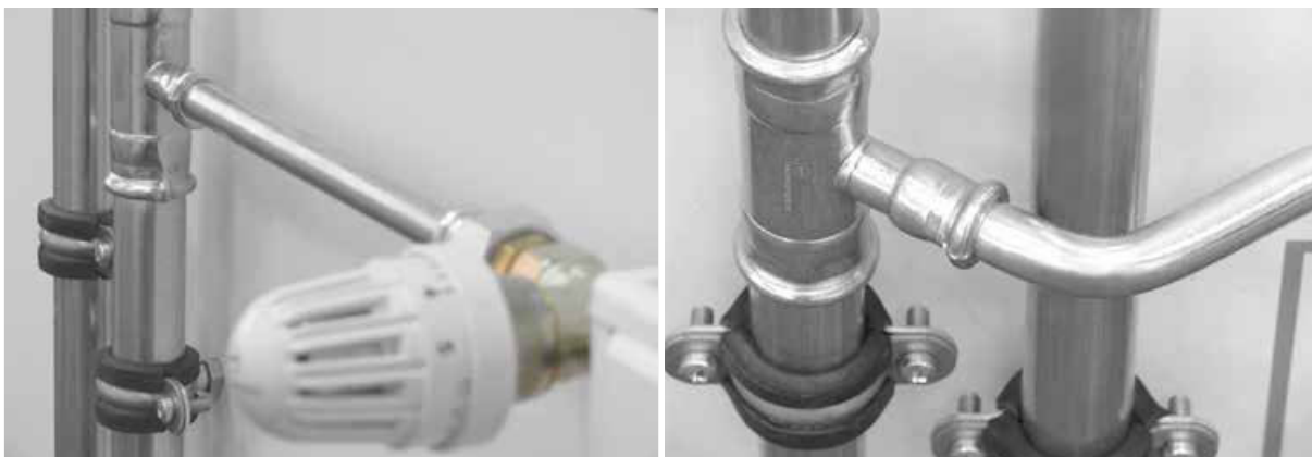
Radijatorski spoj (spojna cijev i povratna cijev) u KAN-therm Steel sustavu
